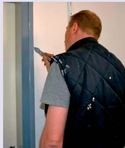
Réfection des peintures dans les parties communes, au 28 rue de la Tannerie, par un agent de proximité.
