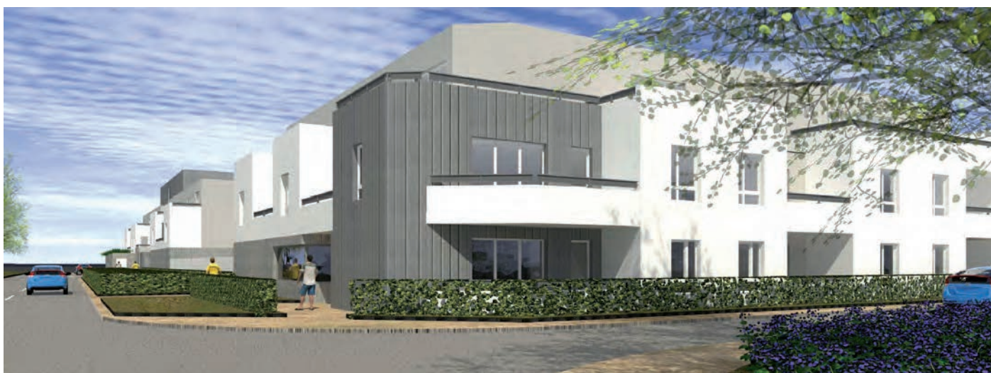
Vue depuis l'angle de la rue du Thymerais et de l'avenue de la République. Au premier plan, la résidence adaptée aux seniors.
