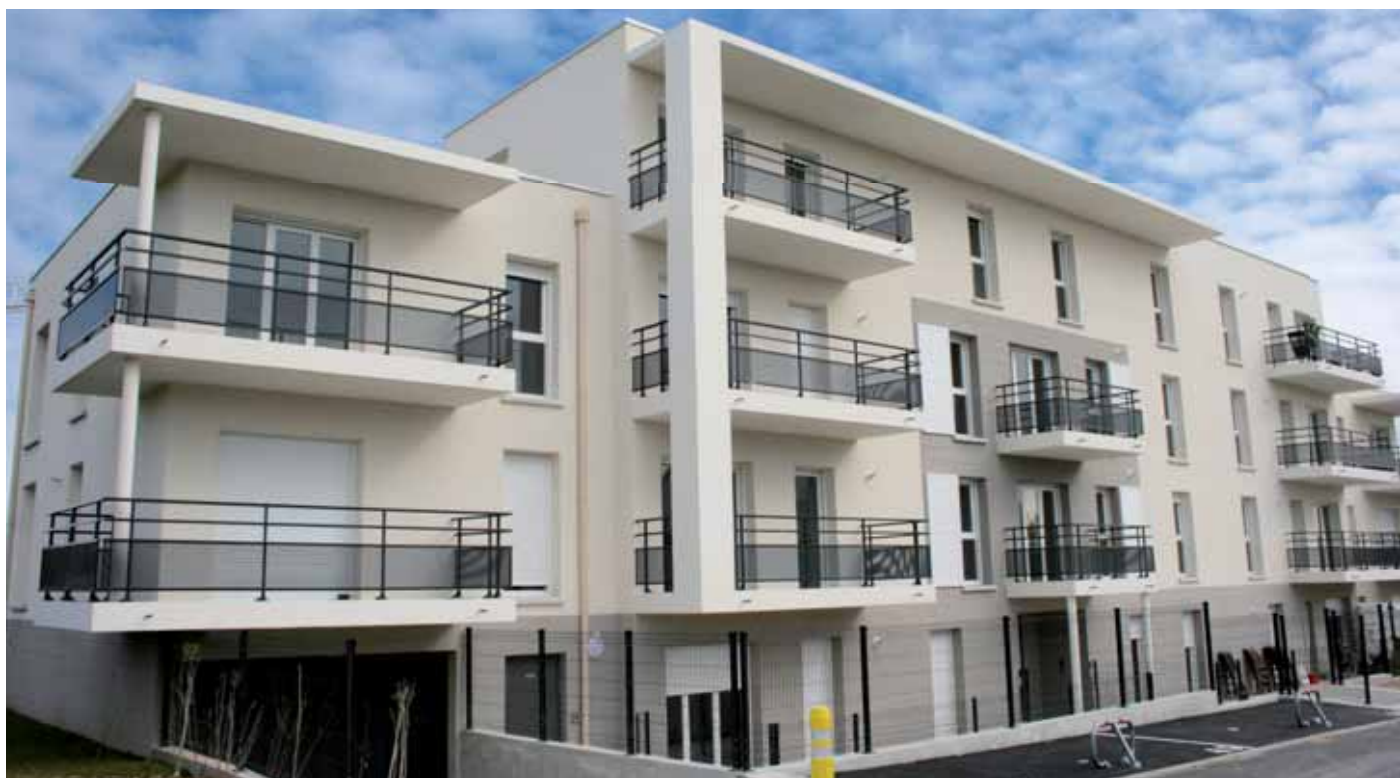
Les 23 logements de ce bâtiment, au "Jardin des Essences" sont gérés par Chartres Métropole Habitat.
