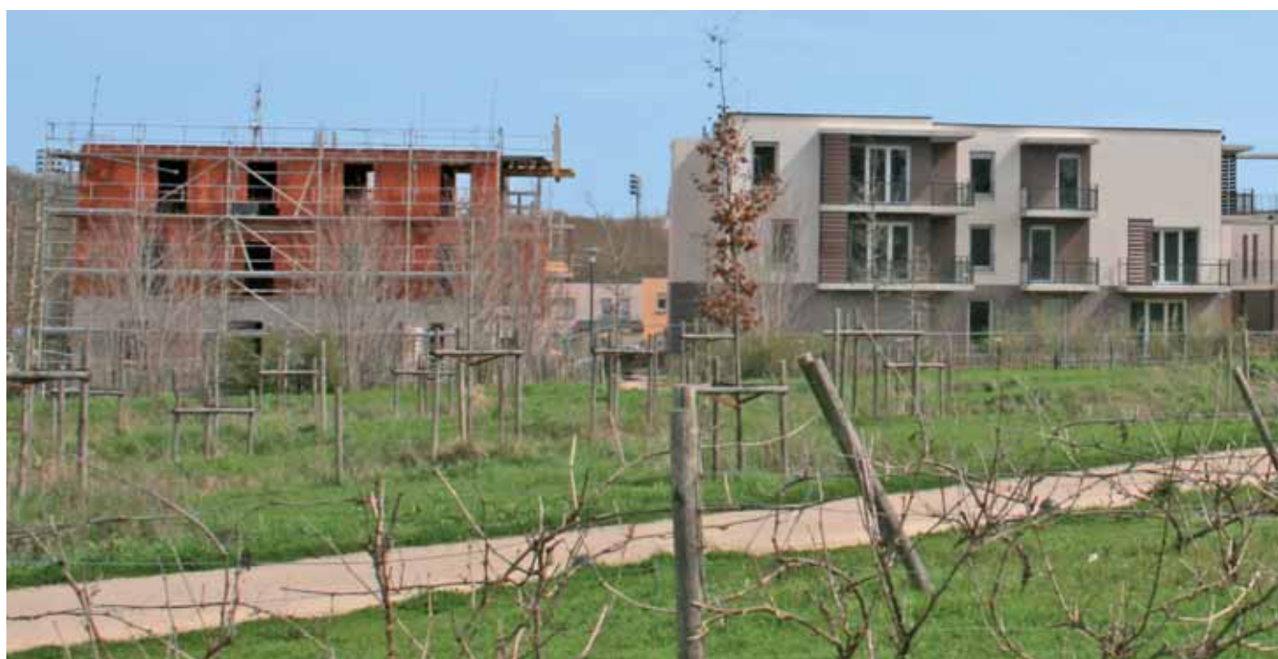
"Les Balcons de la Roseraie" en construction.
