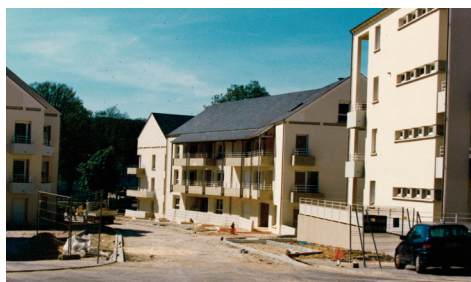
Quartier des Comtesses, les anciennes casernes de la Manutention ne sont plus qu'un ancien souvenir (Archives Chartres Habitat).
