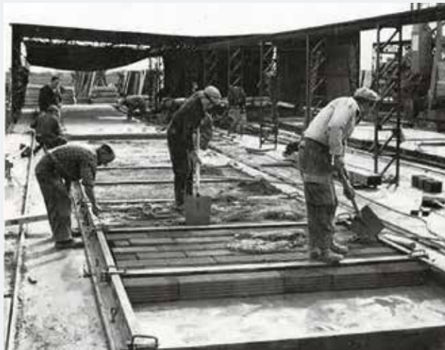
Fabrication de murs intérieurs à Beaulieu, selon le procédé Véran Costamagna.
