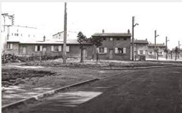
Logements d'urgence rue Constantine.
